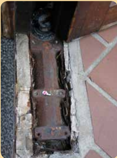
1: Verwitterung und Wasserschaden im Bodenbereich 2 und 3: Sanierungsbedarf
