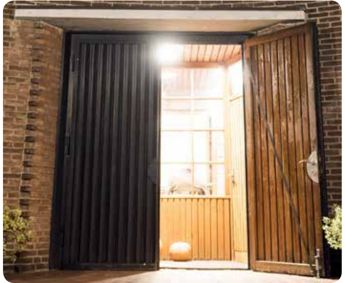
oben: Offene Türe in die Paul-Gerhardt-Kirche Die Türe wird durch die Verstrebung zusammengehalten.
